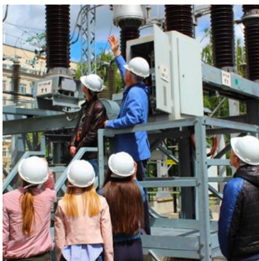
Учебно-производственный полигон «подстанция 110/10 кв»
